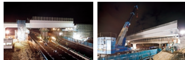
多軸式移動台車による一括架設(10号橋) 大型クレーンによる大ブロック架設(稲荷峰橋)
